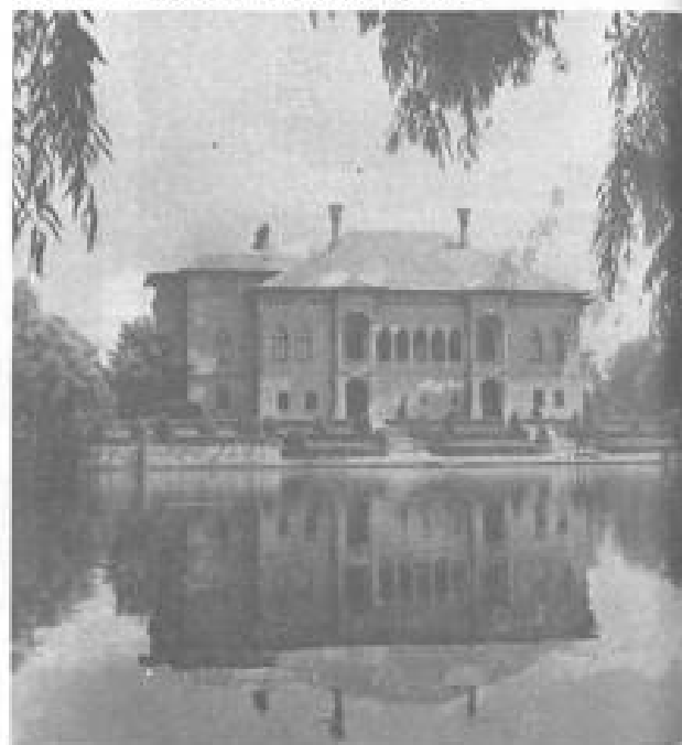
8. Palatul Mogoșoasa, fațada spre lac, 1702
